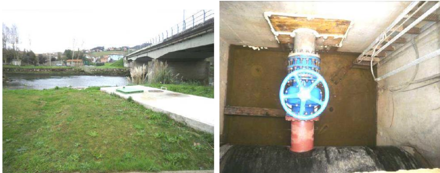
Vista de la arqueta de conexión con el Plan Pas
