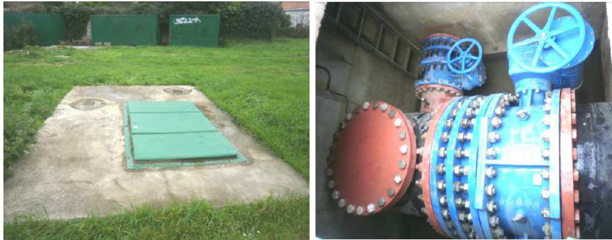
Vista de la arqueta de desagüe
