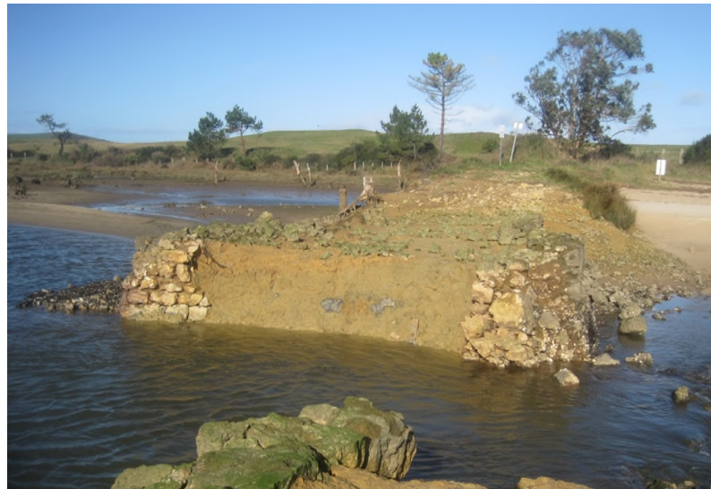
Imagen 4.- Estado de la parte central del dique
