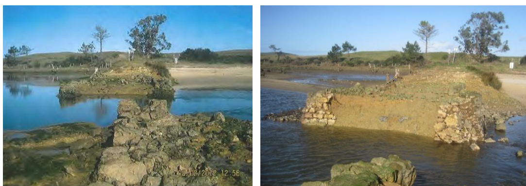
Ilustración 2. Estado actual de la parte central del dique.
