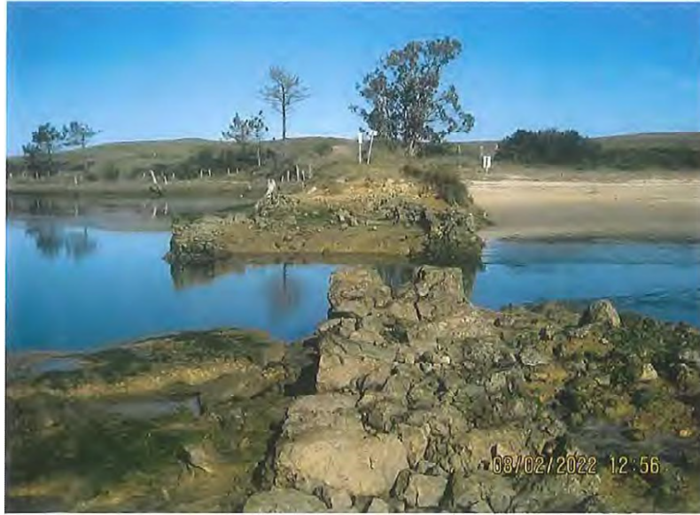
Imagen 3.- Estado de la parte central del dique
