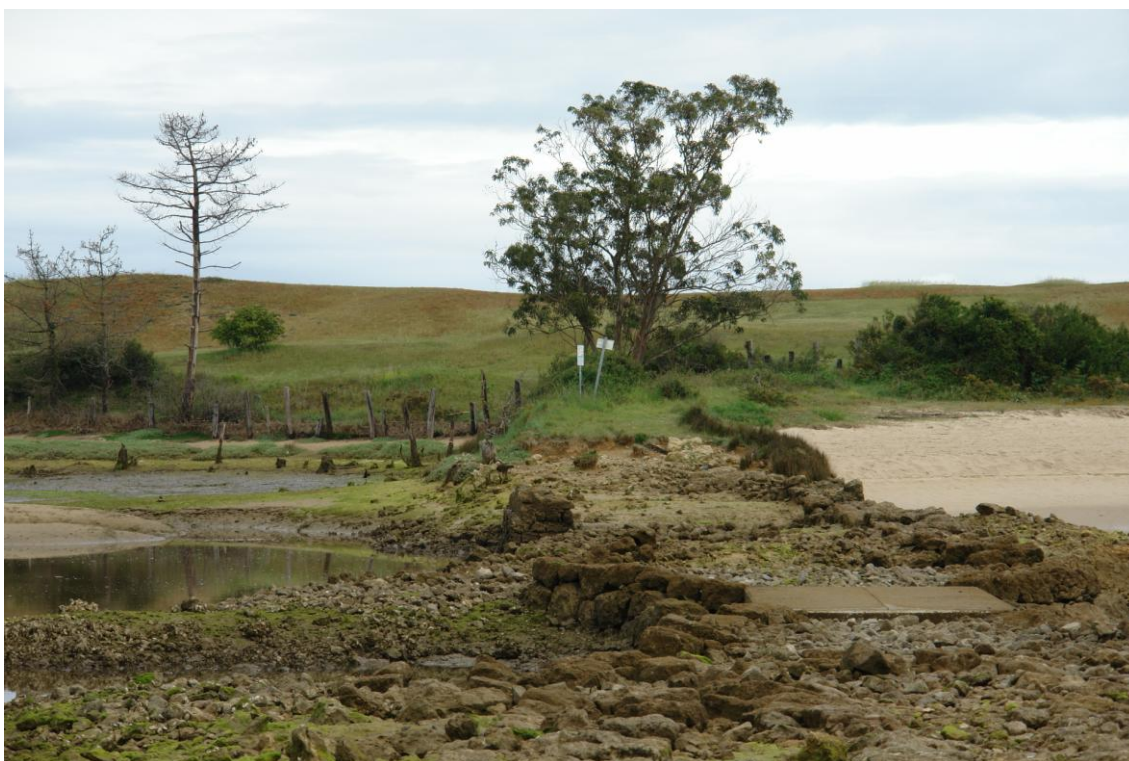
Ilustración 7. Estado actual del dique.
