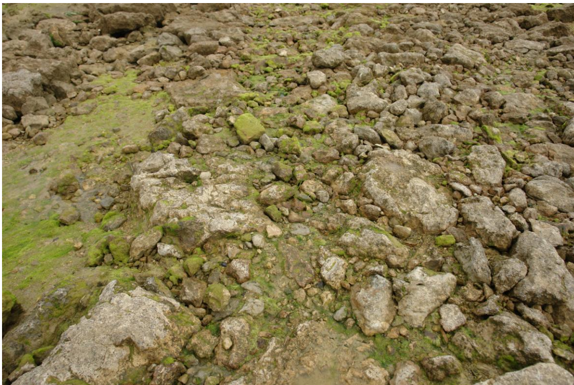
Ilustración 8. Detalle del dique.
