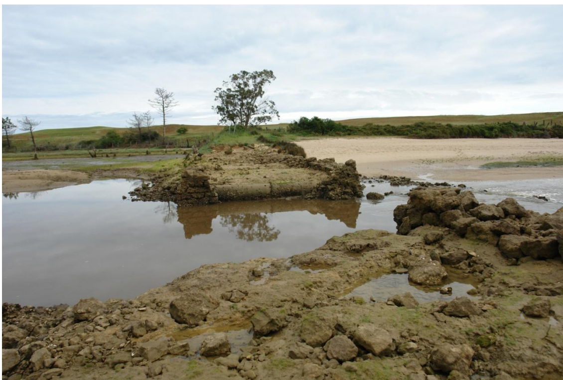
Ilustración 2. Estado actual del dique.
