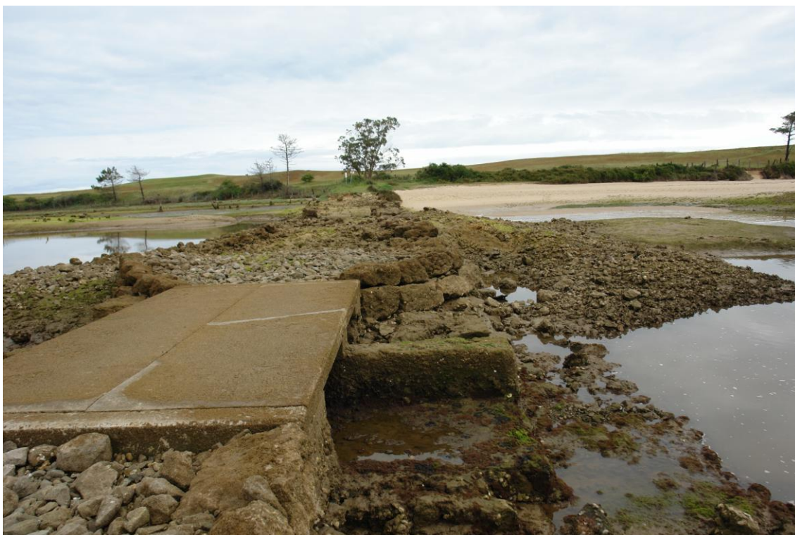
Ilustración 10. Losa del dique.
