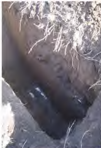
Interior de la cata C-3, en la que se detecta la roca a 1,5 m.
