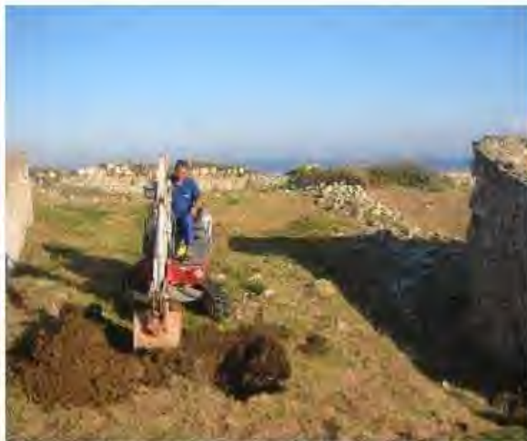
Situación de la cata C-1.
