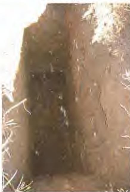
Interior de la cata C-1 en la que se observa el relleno de tierra vegetal y la roca en el fondo.
