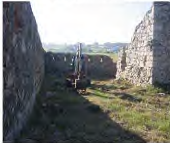
Situación de la cata C-3
