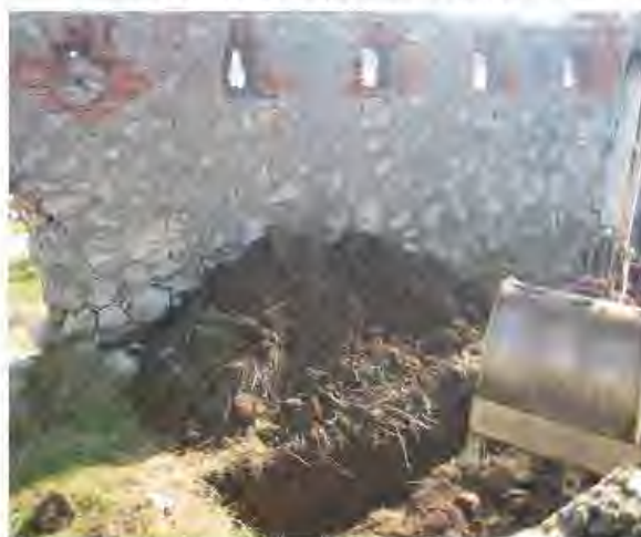
Aspecto de los rellenos de la cata C-3, con tierra vegetal y restos antrópicos heterogéneos.
