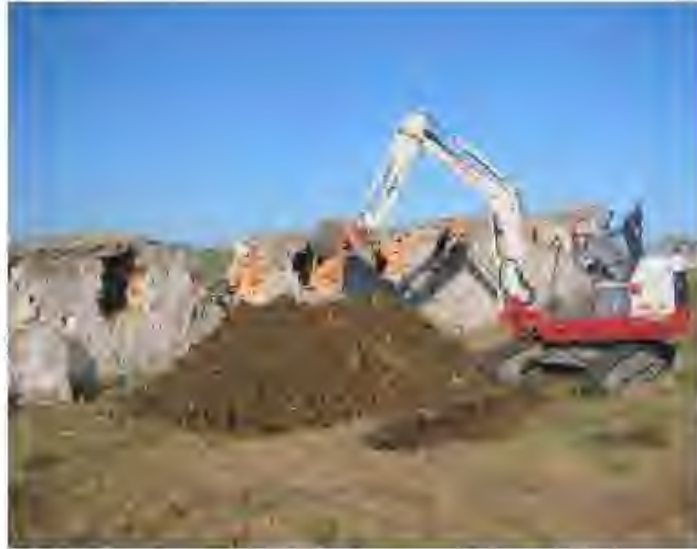
Aspecto del relleno de tierra vegetal, encontrado en la cata C-1
