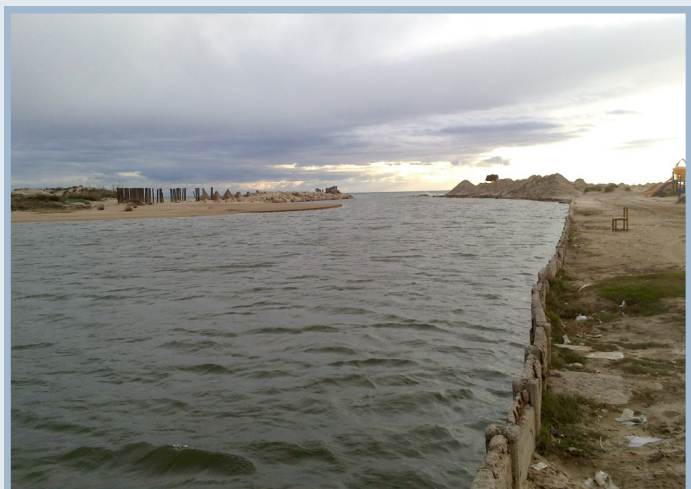
Imagen 10. Imagen del vertido/cauce.
