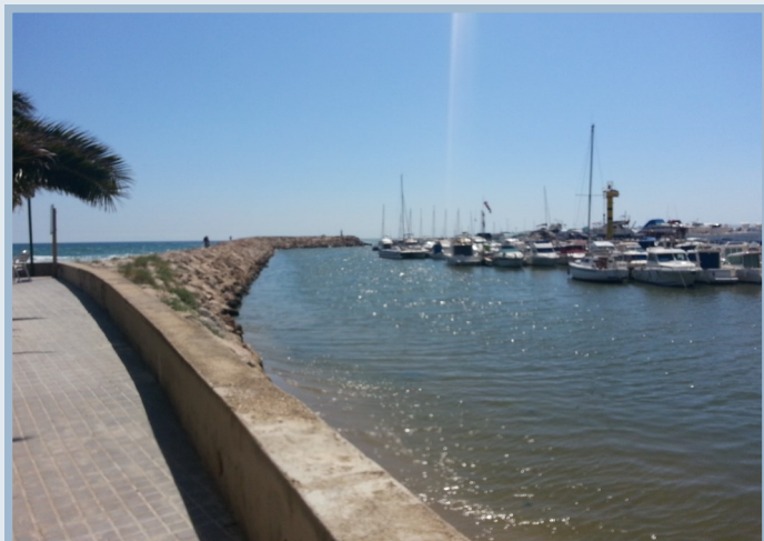
Imagen 9. Imagen del vertido/cauce.
