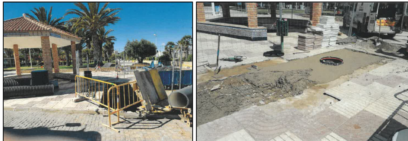
Obras de reparación ejecutadas anteriormente
