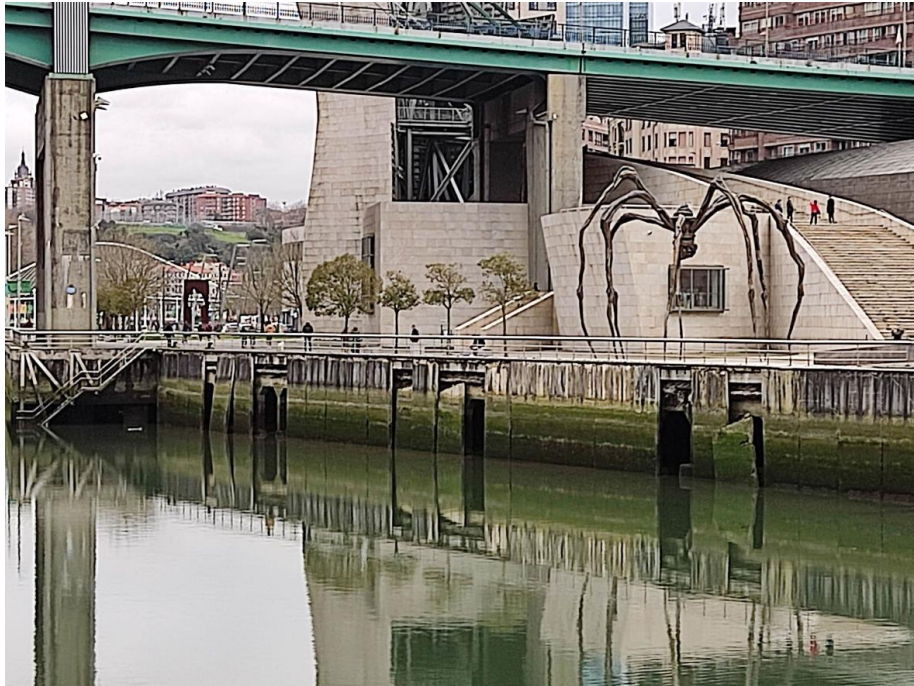
1.- Vista general de zona de actuación
