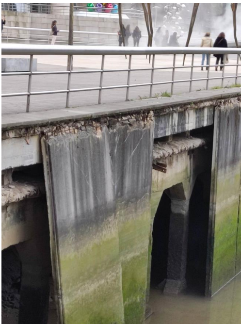
5.- Deterioro de paneles prefabricados y rotura de anclajes al muelle
