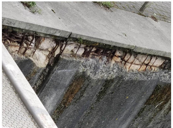
5.- Deterioro de paneles prefabricados y rotura de anclajes al muelle
