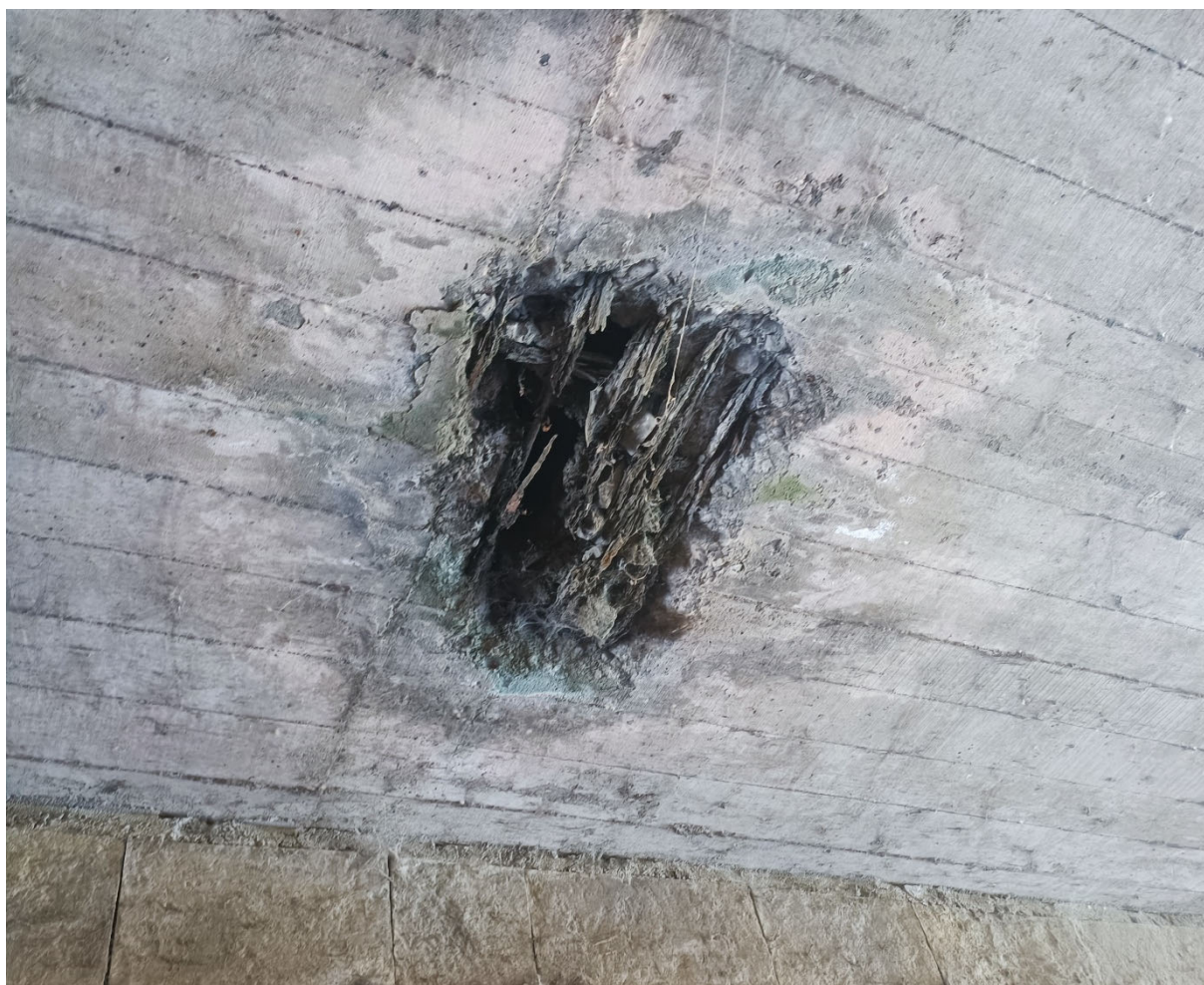
Ilustración 3. Estado actual de los sumideros, similar en ambos casos.
