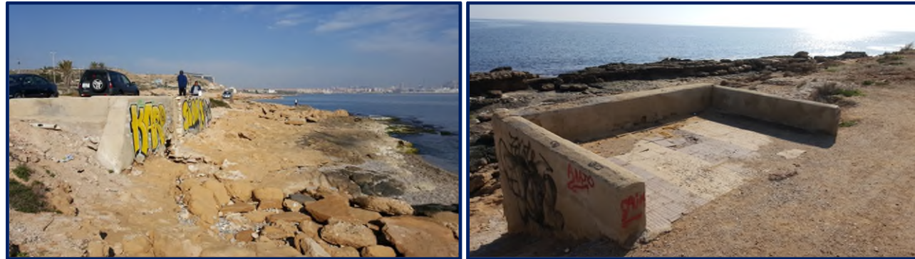
Fotografía 11. Elementos para demoler. Elaboración propia.
