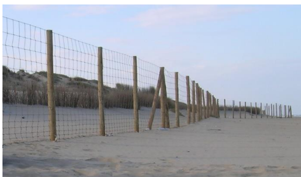
Imagen 23. Recintos de protección adaptables a la zona definida como vivero de obra para la producción vegetal.
