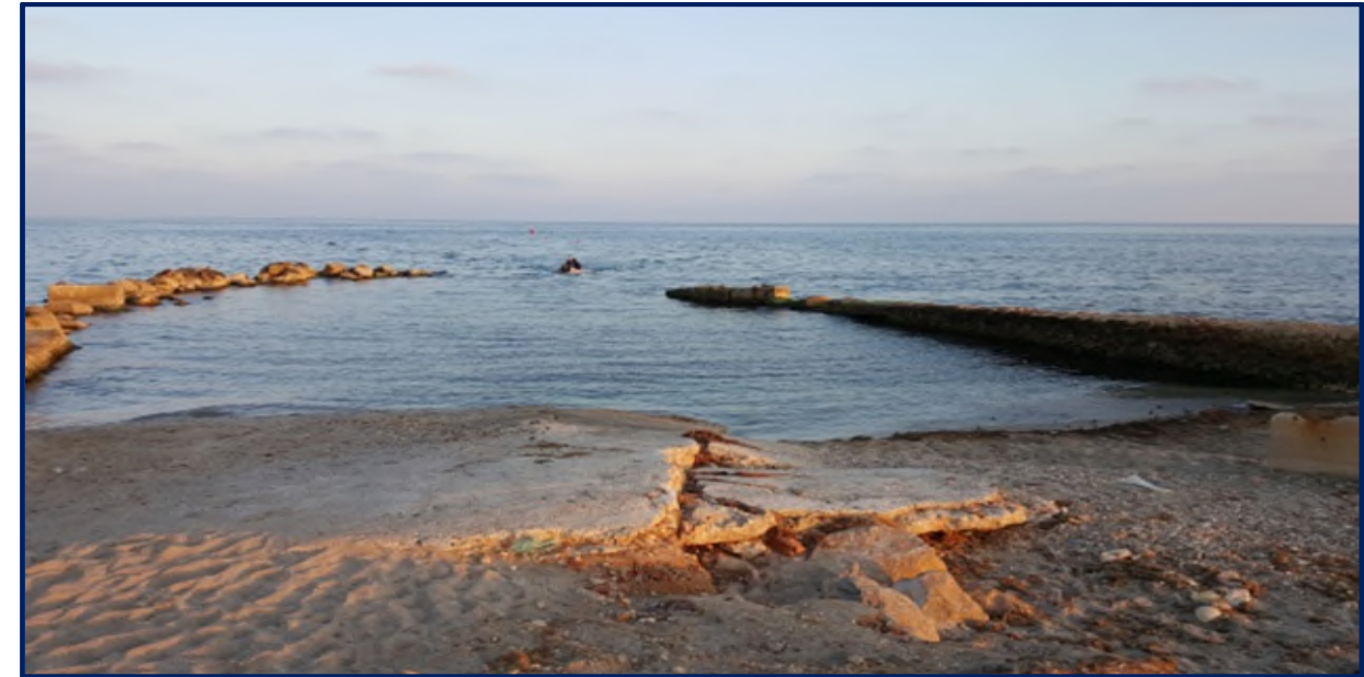
Fotografía 9. Rampa de hormigón y dique de abrigo. Elaboración propia.
