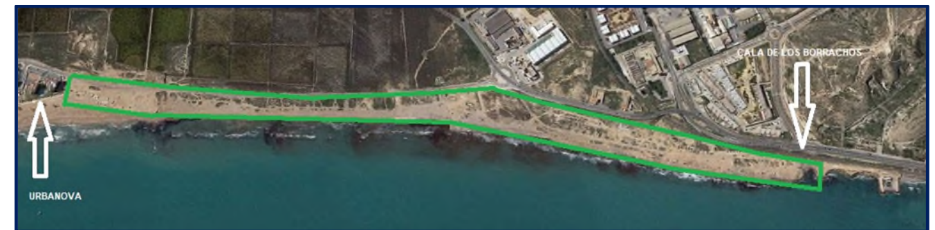
Fotografía 2. Vista general de la actuación. Elaboración propia
