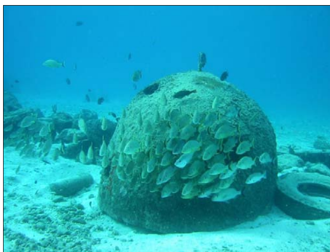
Figura 3. Arrecife artificial sumergido construido con módulos de hormigón
