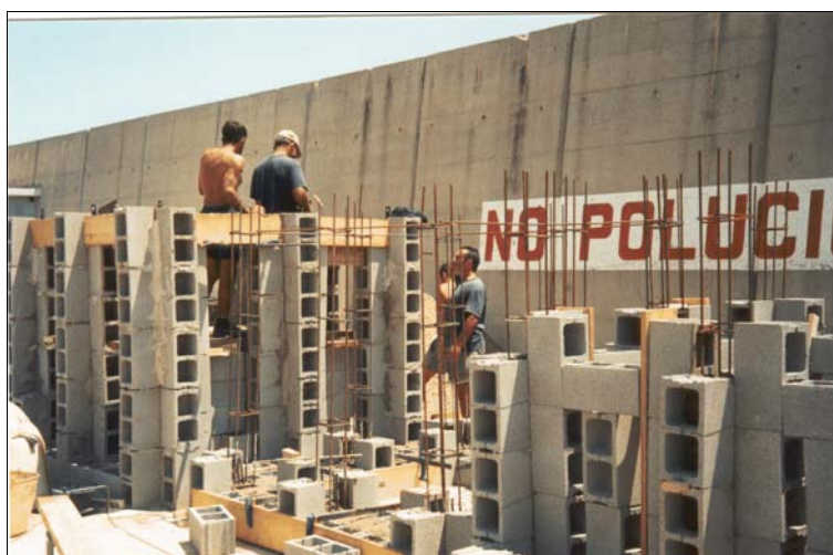
Figura 19. Construcción en el puerto de módulos de producción
