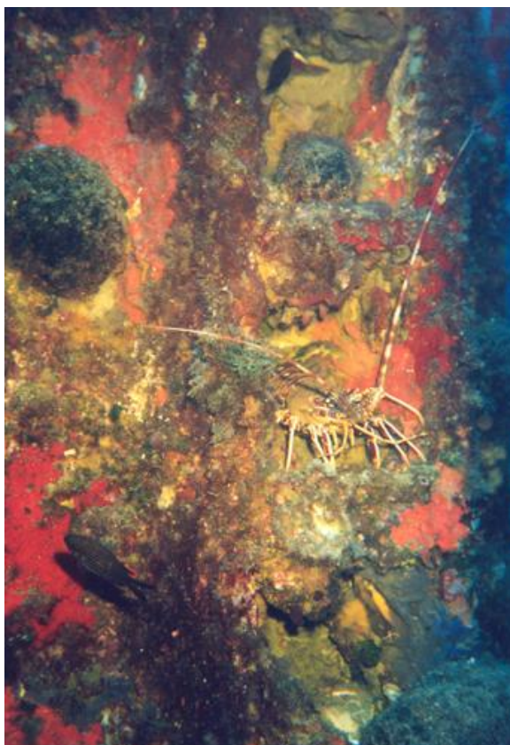
Figura 14. Superficies del AA alveolar de Lloret de Mar a los 9 años de su instalación:
