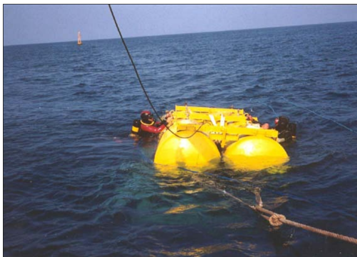
Figura 20. Las operaciones de fondeo pueden llegar a requerir la participación de buceadores
