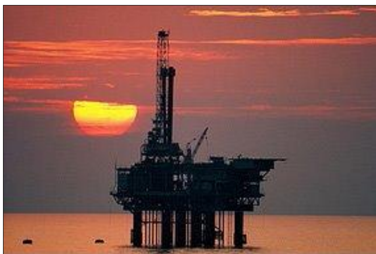
Figura 8. Plataforma petrolífera en funcionamiento
