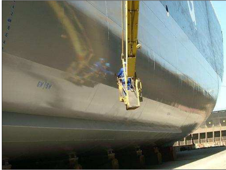
Figura 18. Casco de buque tratado con pintura antifouling
