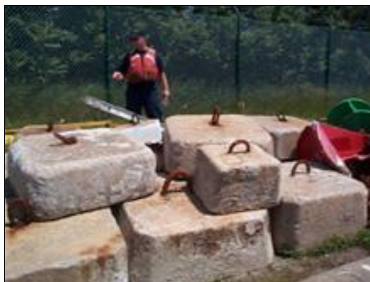
Figura 25. Módulos de arrecifes de hormigón limpios y desmantelados
