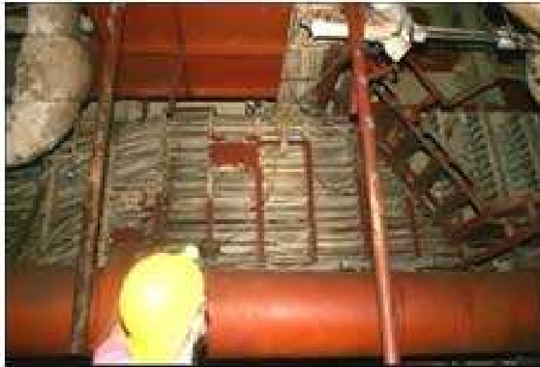
Figura 14. Cableado eléctrico del cuarto motor dentro del ex-USS Oriskany.
