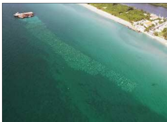
Figura 10. Protección de la línea de costa frente al oleaje mediante un arrecife artificial
