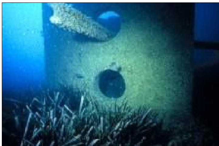
Figura 17. Módulo alveolar con elementos disuasorios sobre una pradera de fanerógamas marinas
