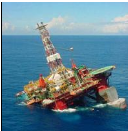
Figura 7. Hundimiento de una plataforma marina
