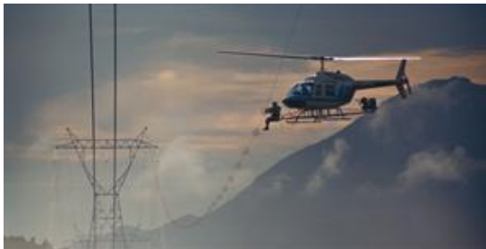
Figura 10.3. Señalización de líneas con espirales salvapájaros desde un helicóptero
