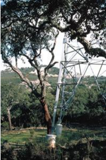
Figura 10.1. Preservación de la vegetación
