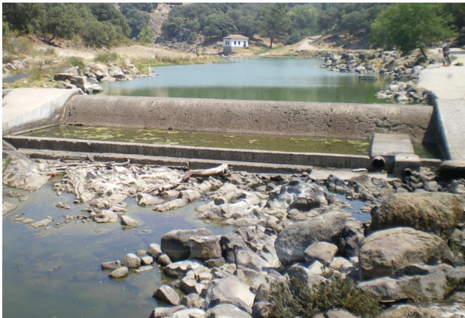
*Figura 1: Imagen del final del verano sobre el azud objeto de estudio en el río Suarez. Se observa como a efectos de migración piscícola aguas arriba tiene un primer salto vertical y a continuación un paso sobre paramento o salto vertical.*
