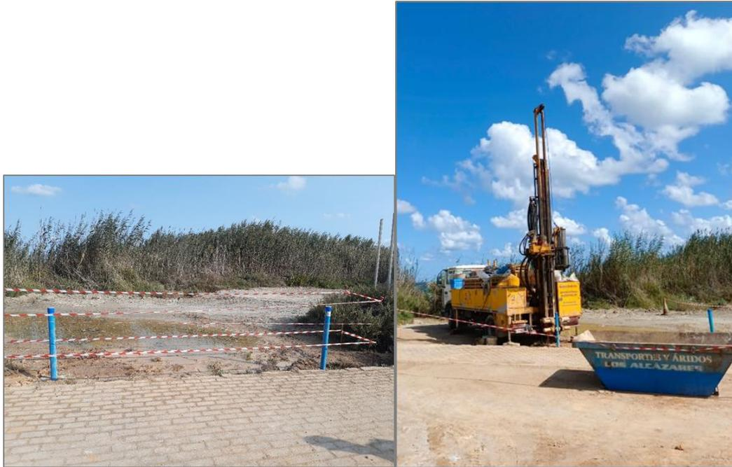
Figura 33. Construcción de los nidos de piezómetros en el humedal de La Hita.
