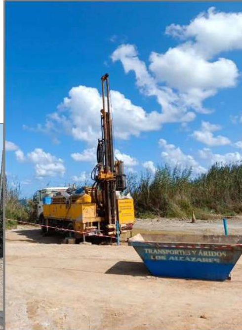
Figura 32. Construcción de los nidos de piezómetros en el humedal de La Hita.
