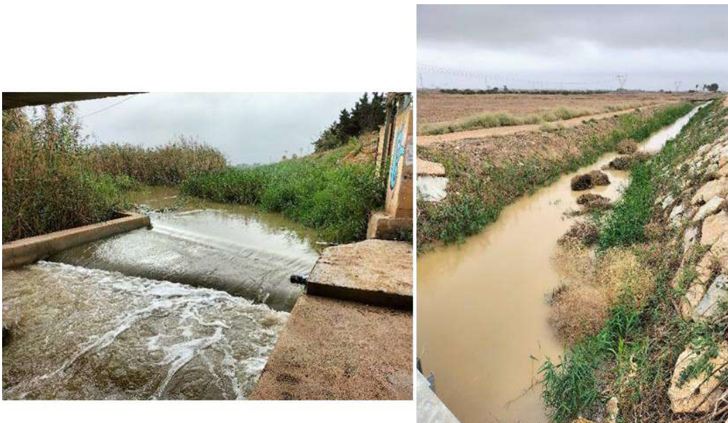
Figura 16. Imágenes de la crecida de las lluvias de octubre. Imagen de la izquierda: desembocadura de la rambla del Albujón; imagen de la derecha: canal D-7 antes de su incorporación a la rambla del Albujón.
