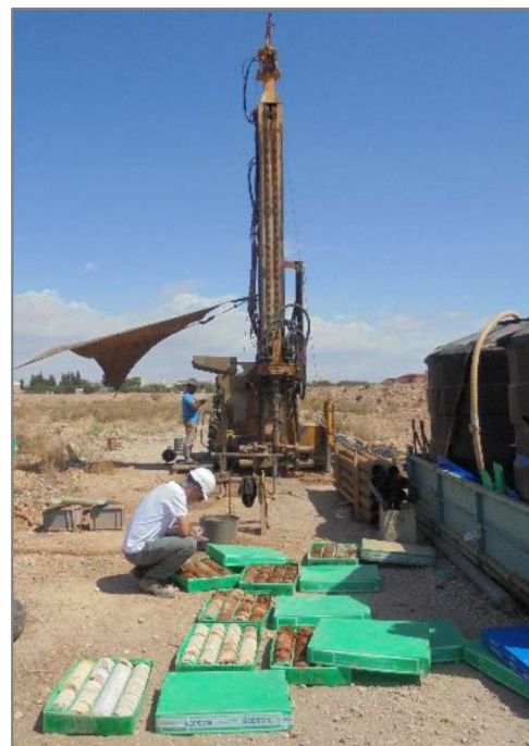
Figura 30. Imágenes de la construcción de los sondeos litológicos.
