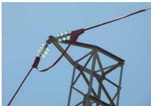
Dispositivos antielectrocución colocados en el tendido eléctrico de Coto del Rey
