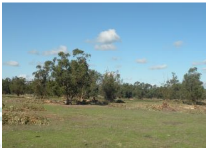
Trabajos de corta de eucaliptos inestables.
