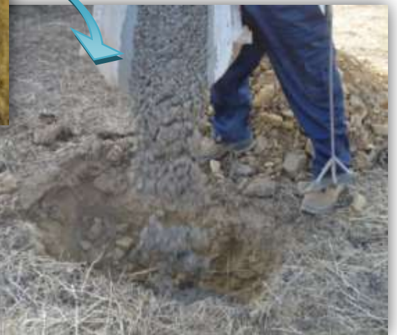
Hormigonado de los hoyos
