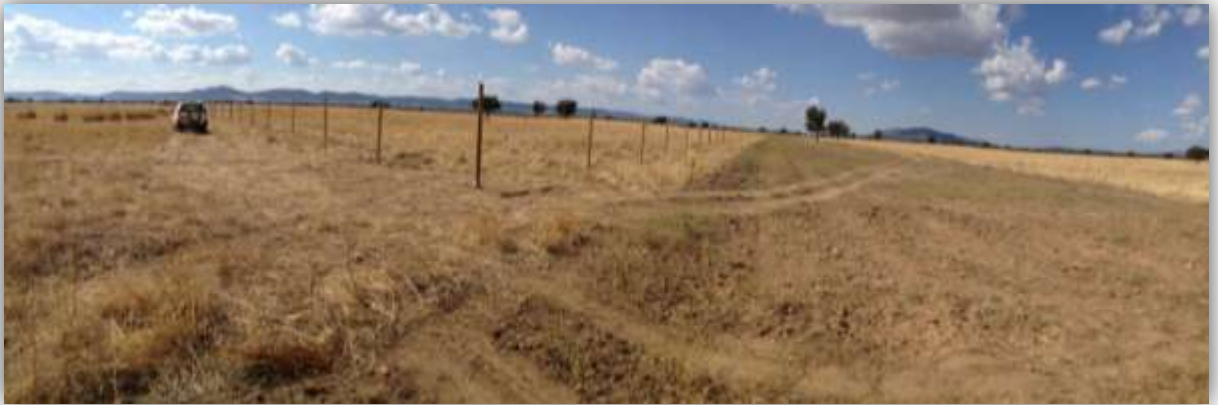
Panorámica final de una esquina del vallado perimetral ya terminado
