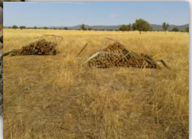
Postes de madera tanalizada en las zonas de acopio
