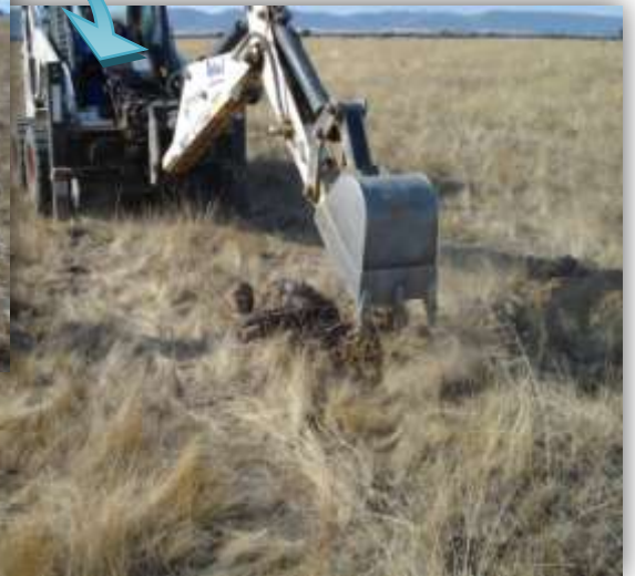
Replanteo de la actuación
