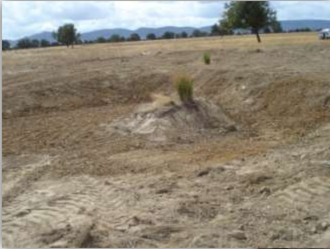
Desarrollo de los trabajos de excavación y movimiento de tierras
