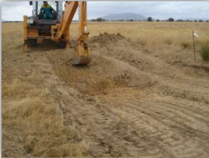
Realización de los trabajos de excavación y acondicionamiento
