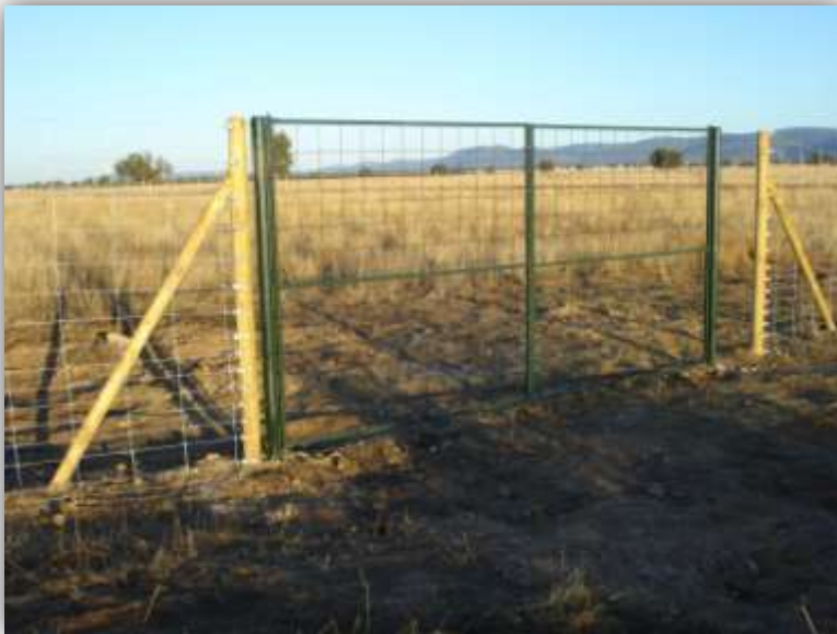
Detalle de la puerta de paso para maquinaria, y hueco para una puerta peatonal
