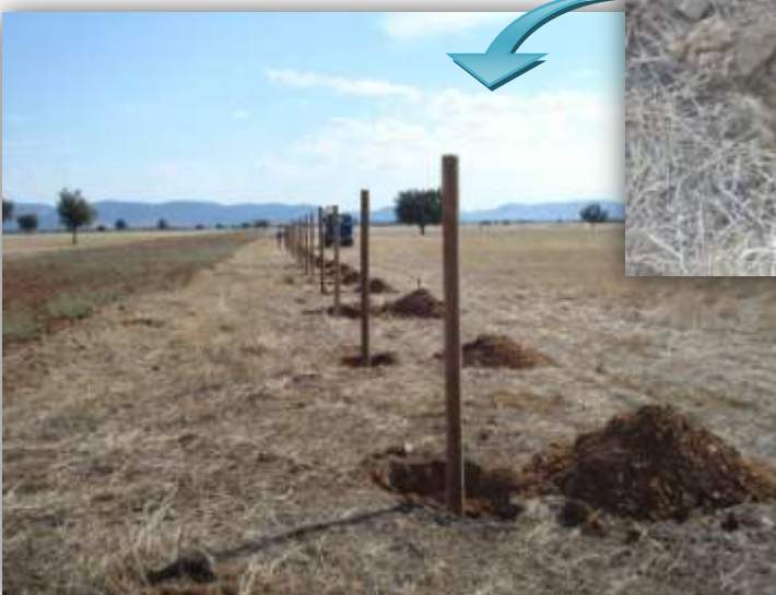
Colocación de postes
