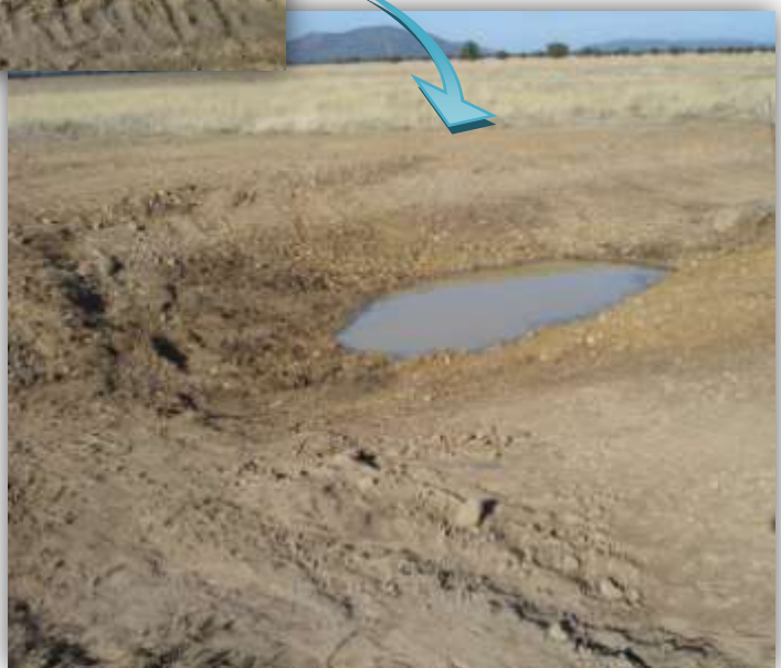
Creación de los taludes y finalización de la charca
