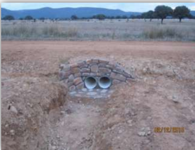
Paso de agua una vez finalizado.
