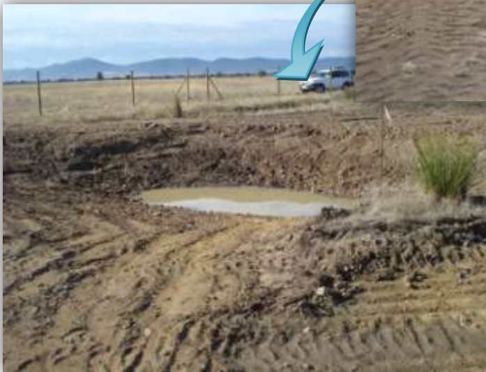
Creación de los taludes y finalización de la charca
