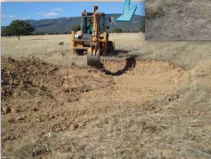
Creación del talud, y marcación del aliviadero
