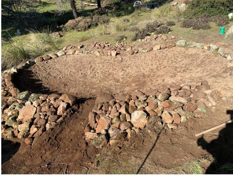
**Foto 64.** Construcción Charca del Jabalí. Acumulo de piedras de la zona para levantar paredes.
