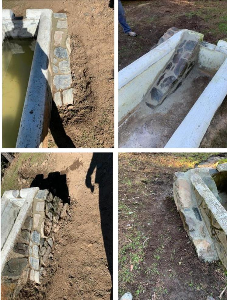
**Foto 18.** Distintas rampas de acceso levantadas en los diferentes pilones.
