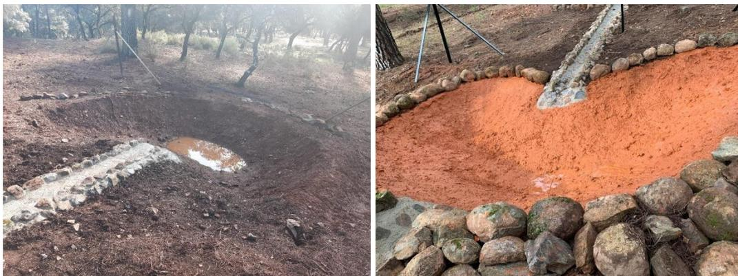
**Foto 58.** Vaso de la Charca de la Centenera. Capa de tierra extendida y compactada sobre la lámina.
