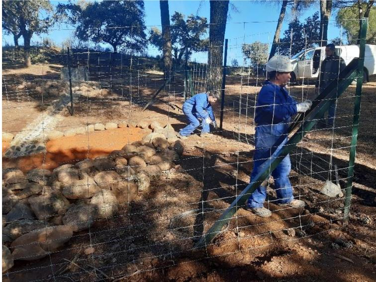
**Foto 59.** Operarios levantando malla de protección.
