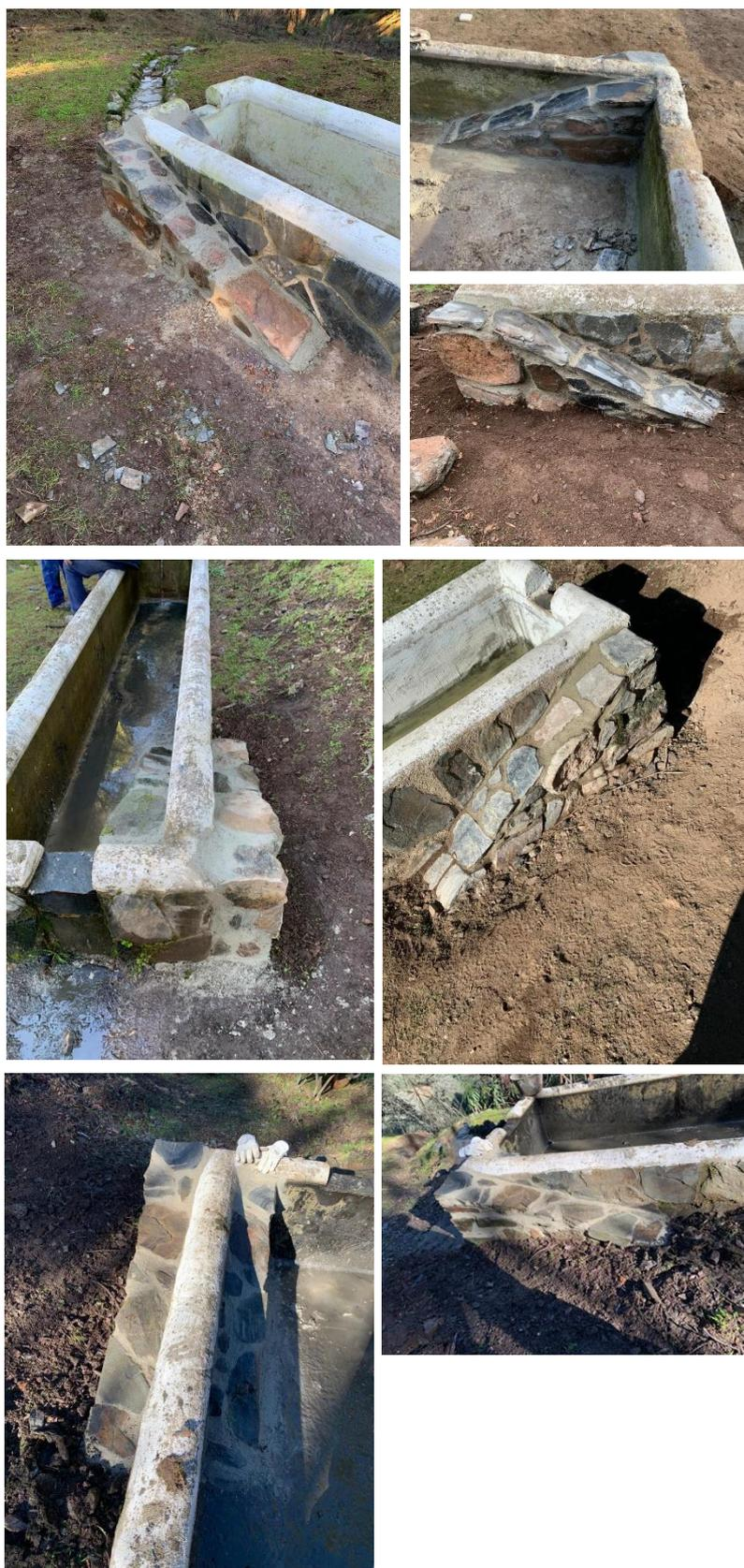
**Foto 17.** Distintas rampas de acceso levantadas en los diferentes pilones.
