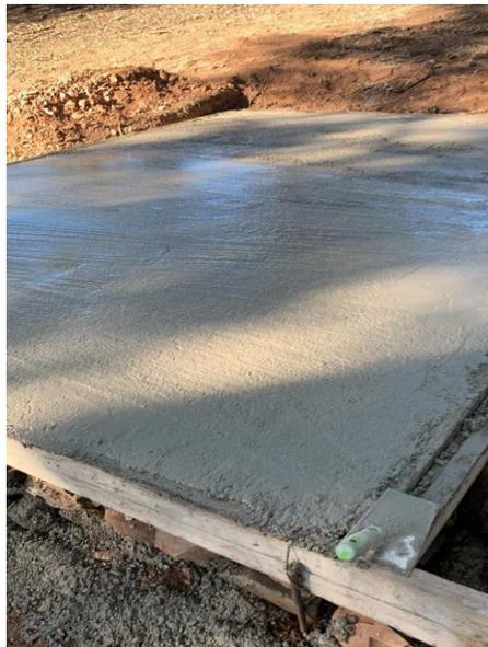
**Foto 10.** Plancha de hormigón sobre la que se levanta el pilar.
