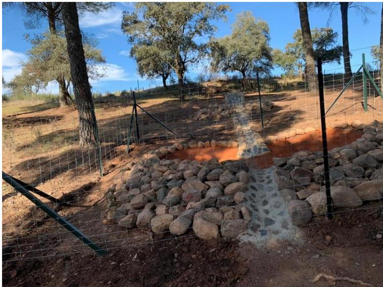
**Foto 60.** Construcción Charca de la Centenera. Se ve el canal de llenado desde el pilón.
