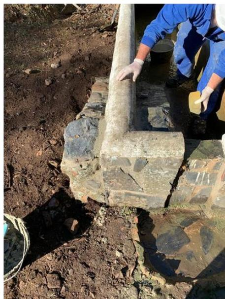
Foto 16. Construcción de rampas de acceso.
