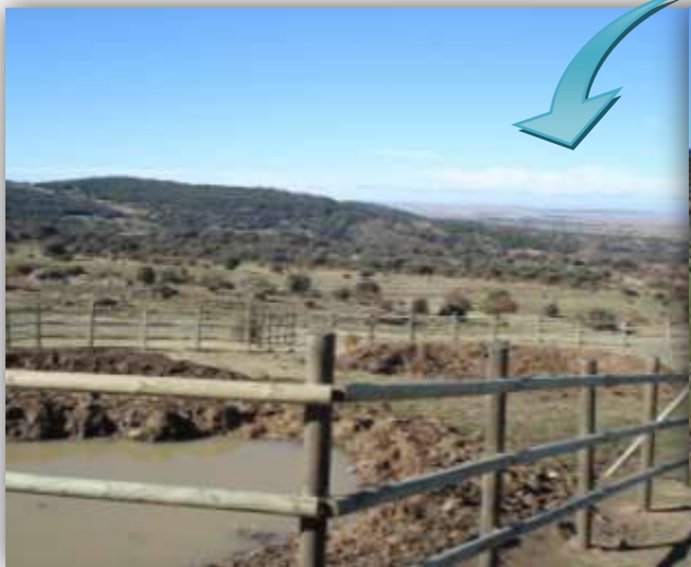
Finalización de los trabajos, con la instalación de vallado perimetral
