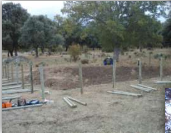
Colocación del cerramiento
