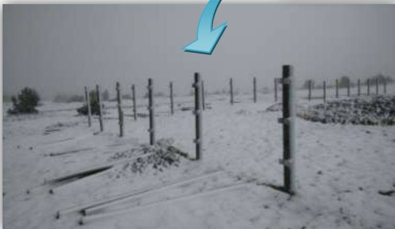
Finalización de los trabajos de vallado perimetral
