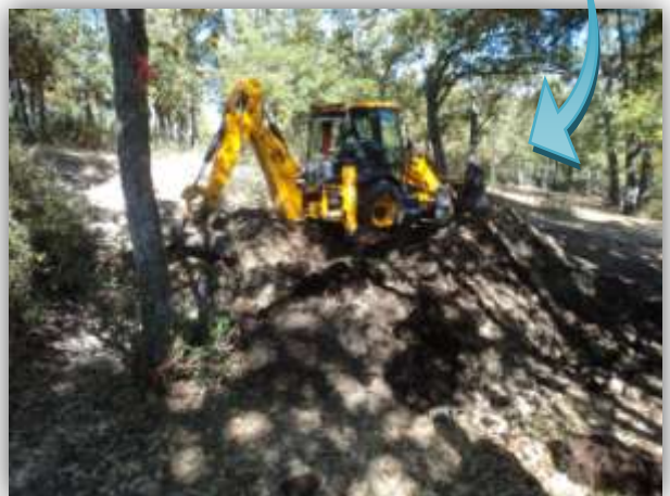
Realización de las labores de excavación y acondicionamiento
