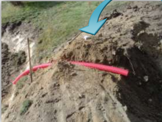
Excavación y limpieza, y conexión entre distintas charcas
