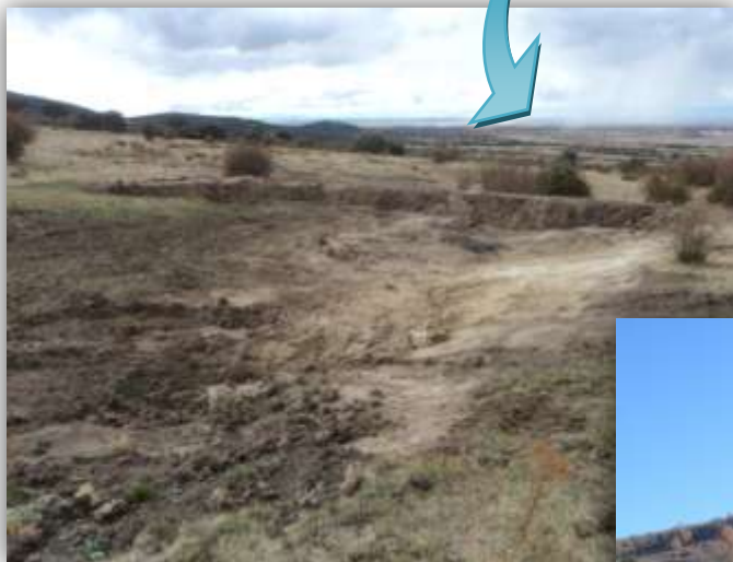
Finalización de los trabajos y cerramiento
