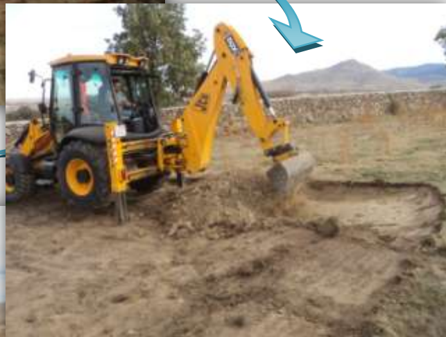
Apertura del vaso con maquinaria, y desarrollo de los trabajos
