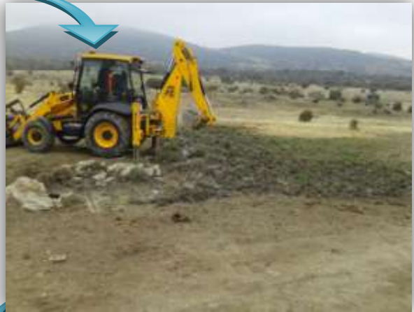
Inicio de la excavación
