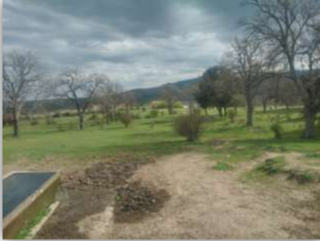
Panorámica del emplazamiento de las actuaciones antes de acometerse éstas, y comienzo de la excavación
