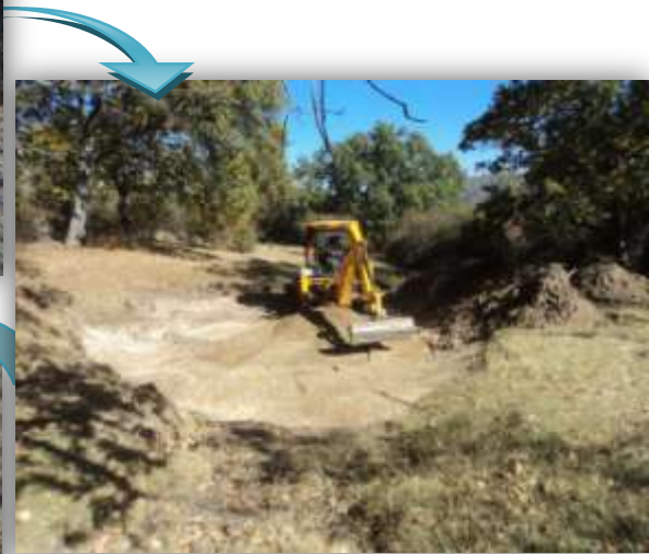
Excavación y limpieza, y conexión entre distintas charcas
