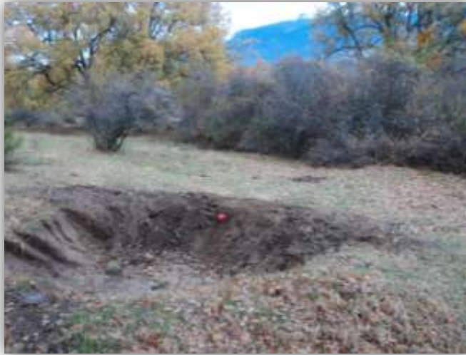
Tubo de desagüe colocado
