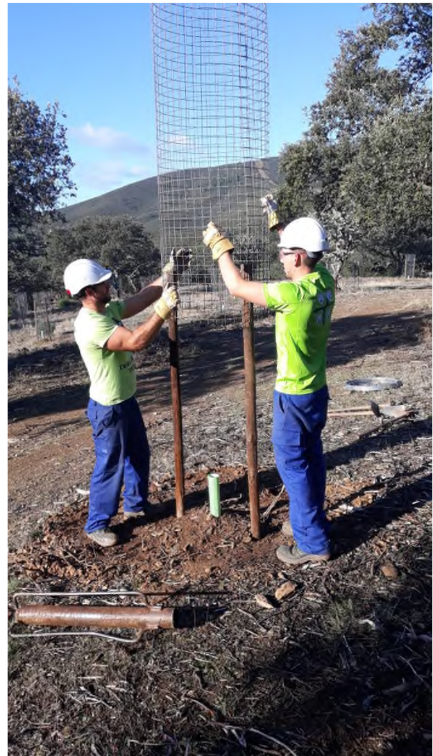
Colocación de las jaulas
