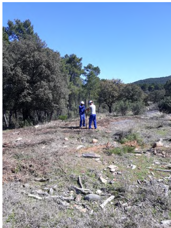
Colocación de postes
