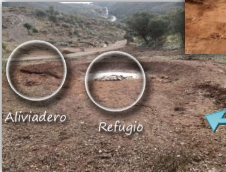
Finalización de las actuaciones; apertura del aliviadero y creación de refugio en el lecho
