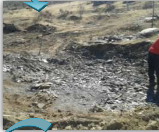
Desarrollo de los trabajos; Limpieza manual tras la apertura con maquinaria
