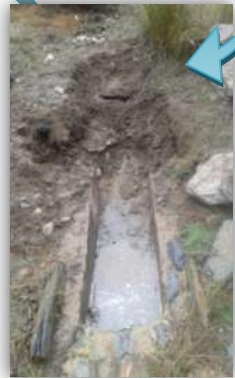
Renovación de la captación de agua y desatascos en el caño de alimentación, y nueva arqueta de registro con drenaje para evitar atascos
