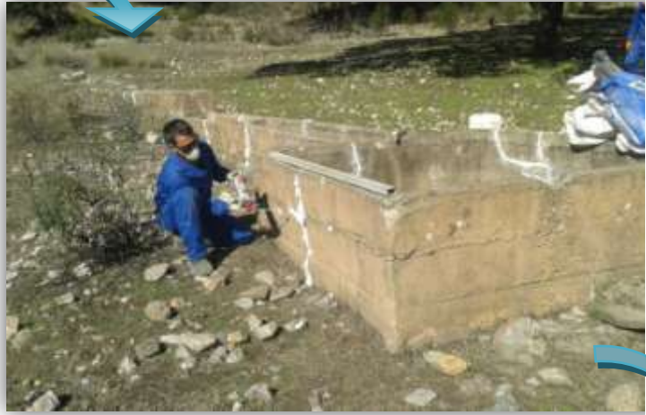
Reparación de grietas y enlucido
