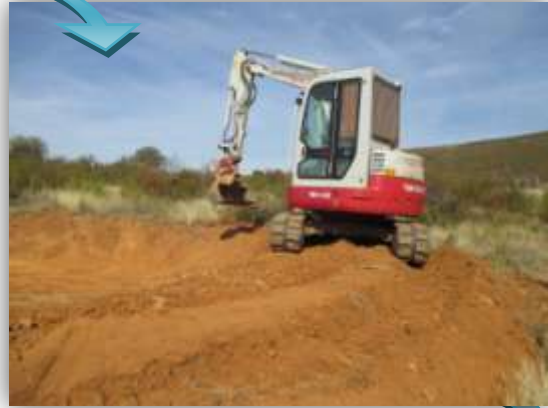
Desarrollo de los trabajos; Construcción del talud con maquinaria
