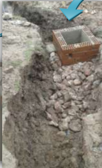
Renovación de la captación de agua y desatascos en el caño de alimentación, y nueva arqueta de registro con drenaje para evitar atascos
