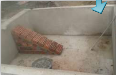
Enlucido de pilas, y acceso para anfibios
