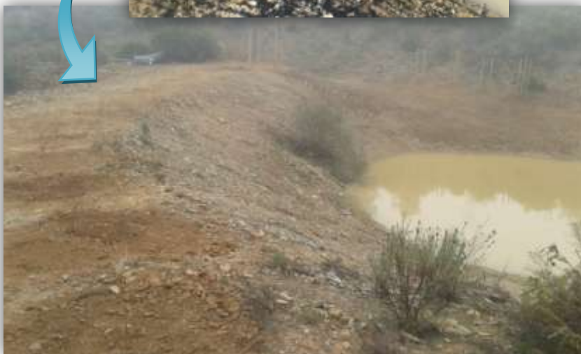
Finalización de las actuaciones; vista general
