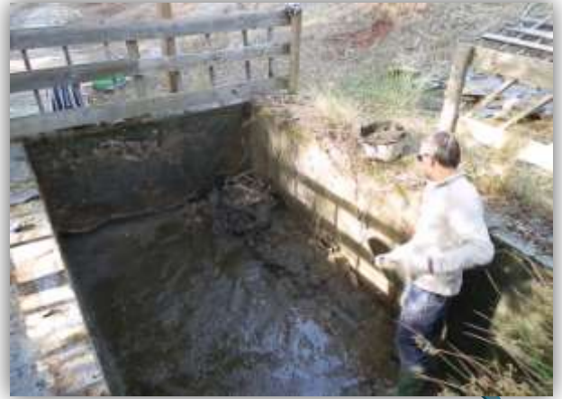
Limpieza de escorias guardando el fango para su reintroducción, y detalle de rampa terminada
