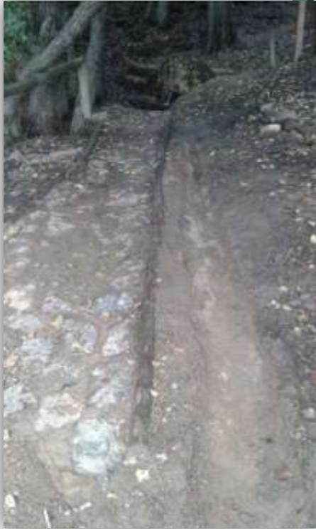
Estado inicial tras la limpieza del drenaje en la zona accesible
