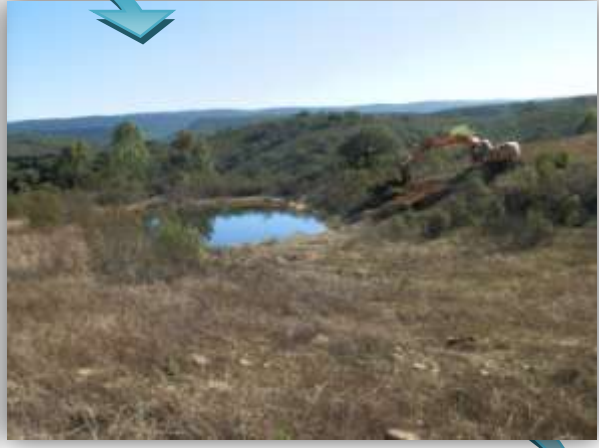
Desarrollo de los trabajos; Máquina en labores de limpieza
