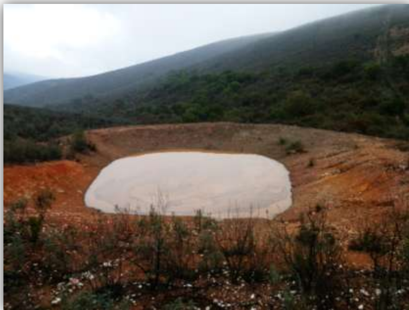
Finalización de las actuaciones; vista general hacia el sureste
