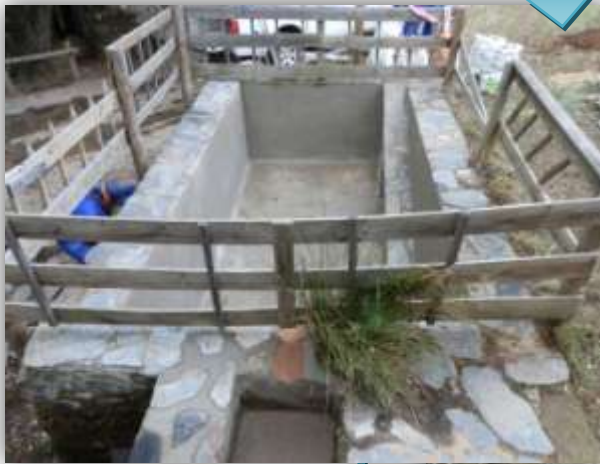
Restauración de pila, pilón y desagües
