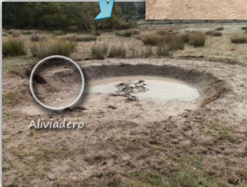
Finalización de las actuaciones; creación del aliviadero y un refugio de piedras en el lecho
