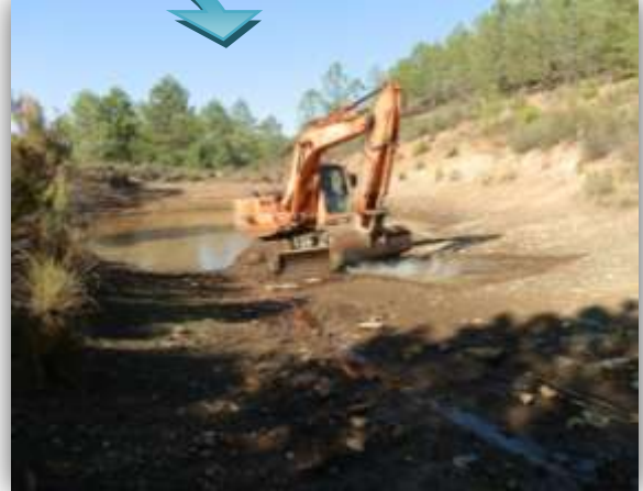
Desarrollo de los trabajos; limpieza del talud con maquinaria
