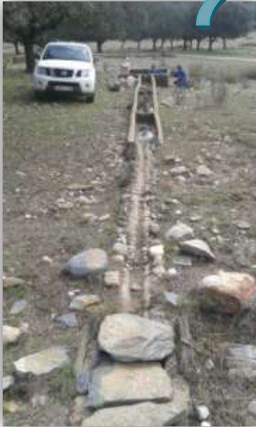
Estado inicial; entrada de agua a las pilas
