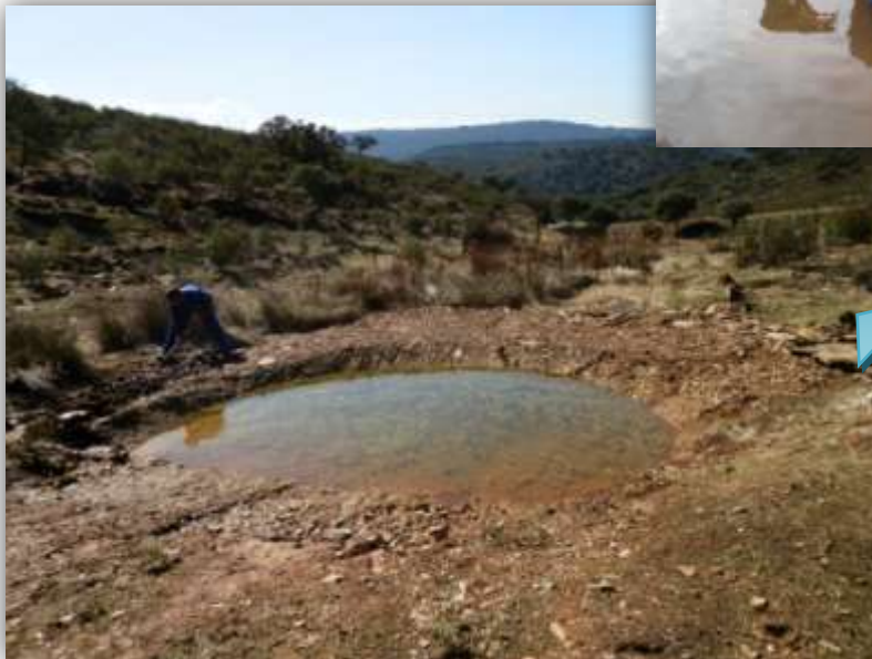
Finalización de las actuaciones; creación del refugio de piedras en el lecho y de un aliviadero
