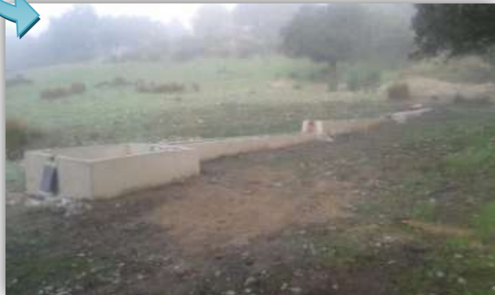
Renovación de la captación de agua y desatascos en el caño de alimentación, y nueva arqueta de registro con drenaje para evitar atascos
