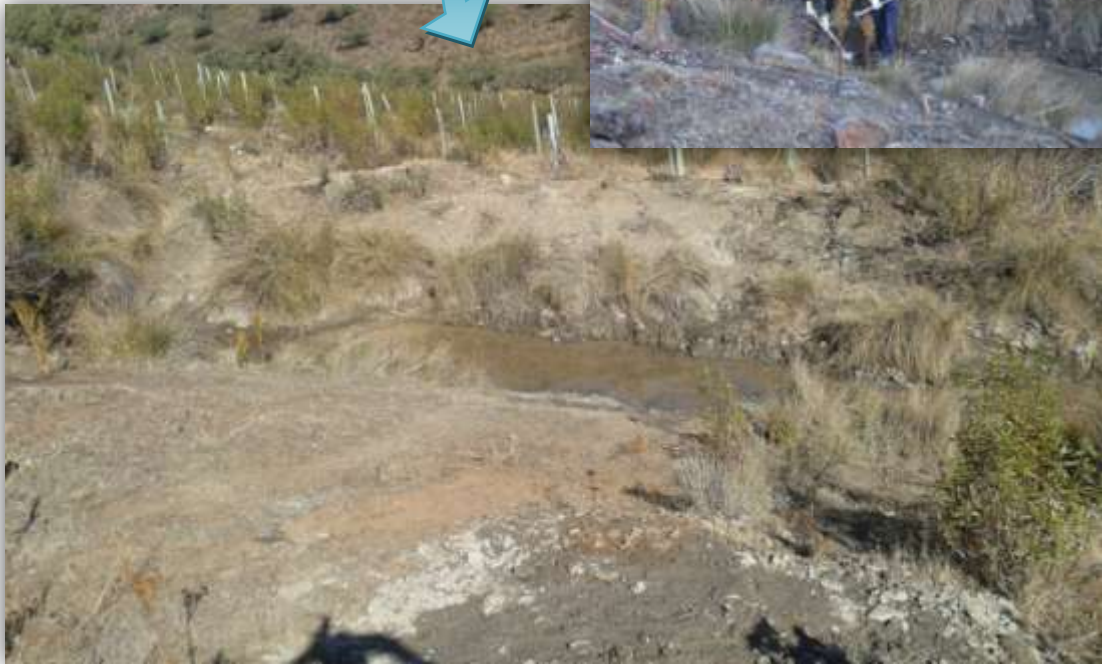
Finalización de las actuaciones; vista general de la charca
