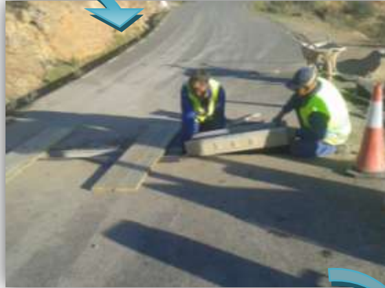
Vaciado e instalación de canaletas de paso, y detalle interior y entrada norte
