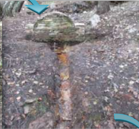
Limpieza de la canaleta de desagüe y reparación de aletas y pila de agua
