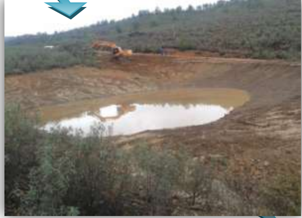
Desarrollo de los trabajos; Máquina en labores de limpieza
