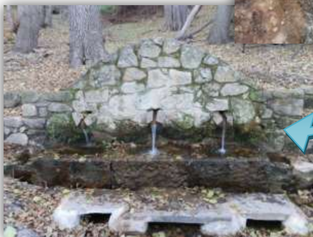
Finalización de las actuaciones; sistema de fugas ya instalado
