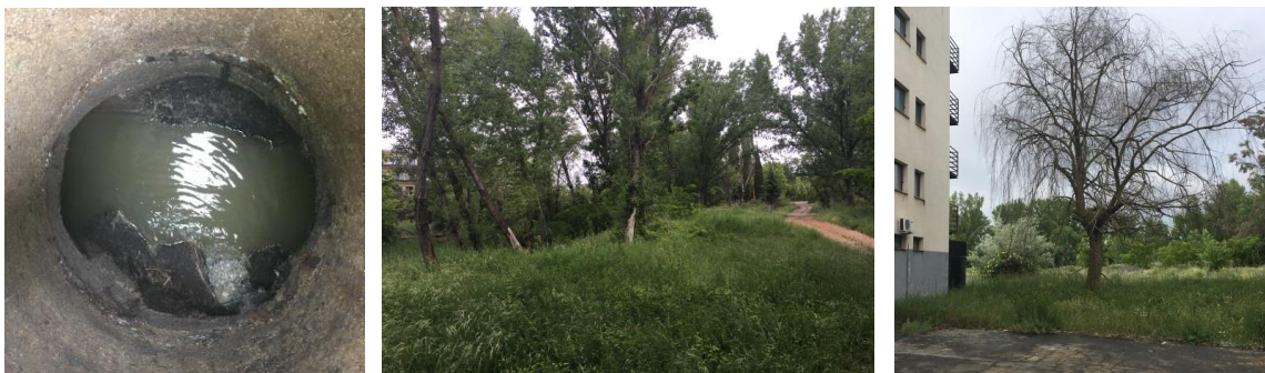
Fig. 12 Pozo acometida colector S-2, y arbolado de parcela en mal estado de conservación.
