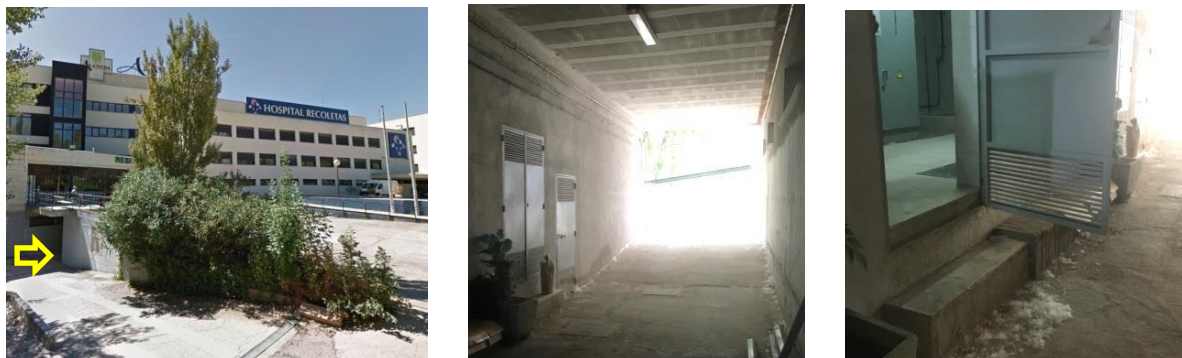
Fig. 27 Rampa 3, zona exterior cubierta y recinto CT.
