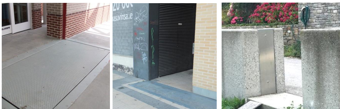
Fig. 37 Barrera metálica hidráulica y esperas de barreras temporales.
