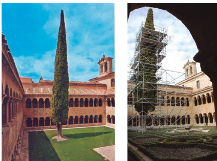
Imagen 13. Izda. Fotografía del Ciprés de Silos en el antiguo Catálogo del ICONA. Dcha. Imagen de 2008 del árbol cuando se realizaron las obras de limpieza de la copa (Bosques sin Fronteras)
